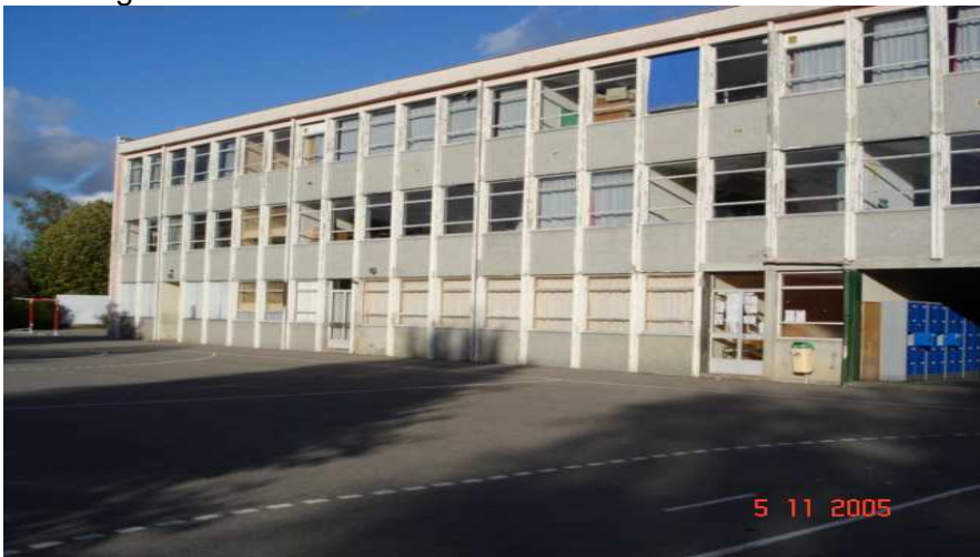
Le collège avant sa rénovation
